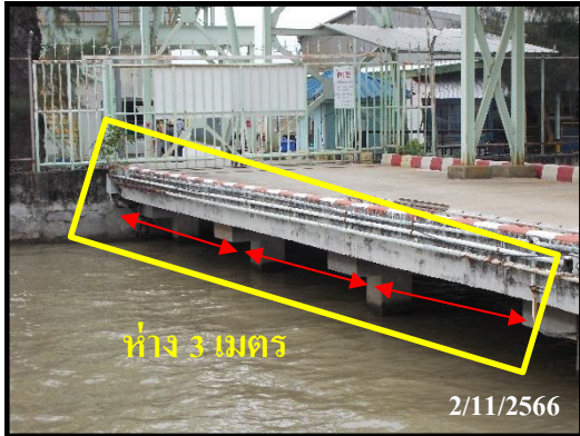
ภาพที่ 12 การออกแบบและก่อสร้างท่าเทียบเรือ ให้มีช่องว่างระหว่างเสาไม่น้อยกว่า 3 เมตร
