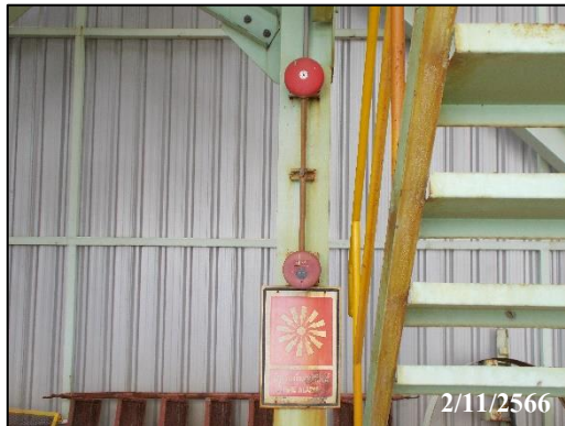
ภาพที่ 16 สัญญาณเตือนภัย บริเวณท่าเทียบเรือ
