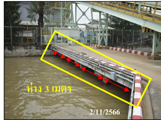
ภาพที่ 12 การออกแบบและก่อสร้างท่าเทียบเรือ ให้มีช่องว่างระหว่างเสาไม่น้อยกว่า 3 เมตร
